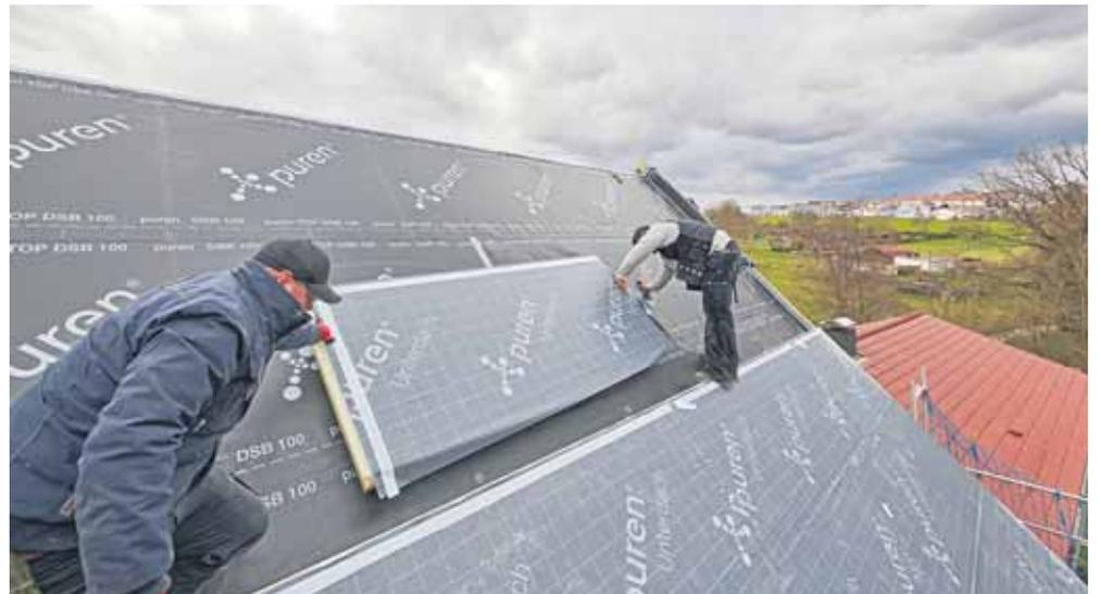
Dämmelemente aus Polyurethan-Hartschaum bieten zusätzlich zur Dacheindeckung Schutz gegen Hagelschlag und Wasser.
